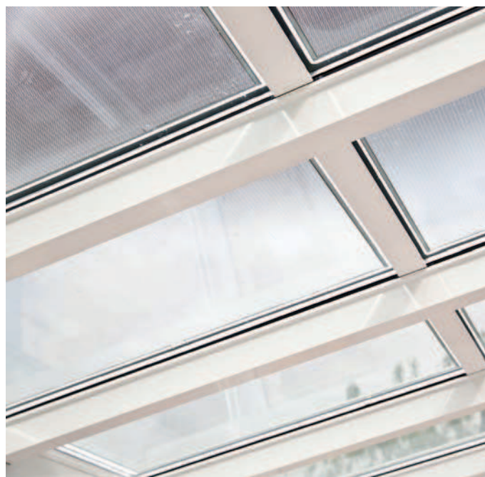
Semitransparente PV-Module montiert mit dem PV 80 System - isoliert-
